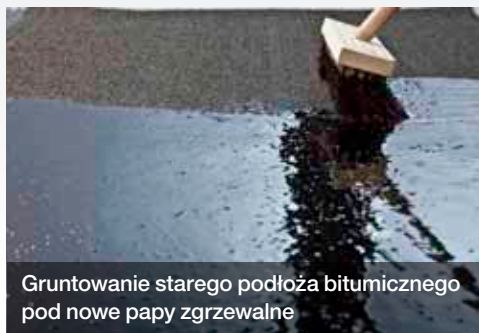
Gruntowanie podłoża pod izolację poziomą fundamentów
