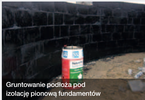
Gruntowanie betonu pod nowe papy zgrzewalne
